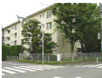
図2 国領住宅従前建物
