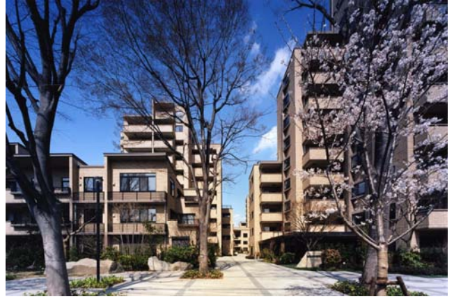
図9 小学校前の公園及び再建建物
