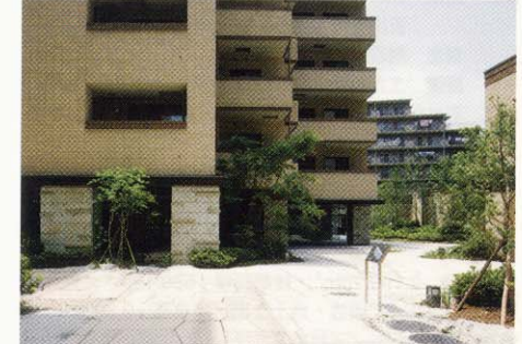
アネックス西棟エントランス方向を見る。左手前が共用のラウンジ。
