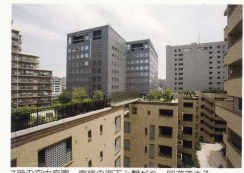
7階の空中庭園。南棟の廊下と繋がり、回遊できる。
